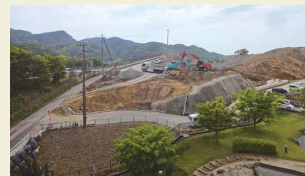
造成工事中の広域ごみ処理施設
