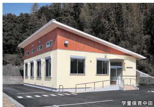
新築や改修が進む学童保育施設
