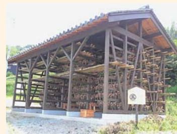
まるご玉葱復活プロジェクトにより建てられたたまねぎ小屋
