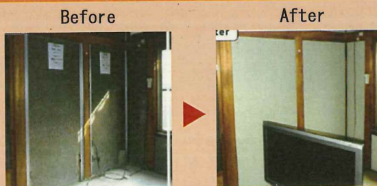
床と天井に壊さず工事を実施
