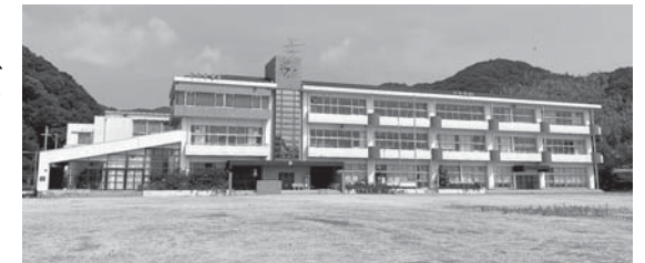
利活用が検討される旧佐野小学校
