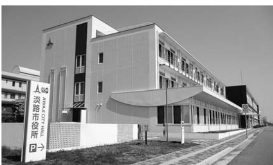
淡路市役所庁舎
