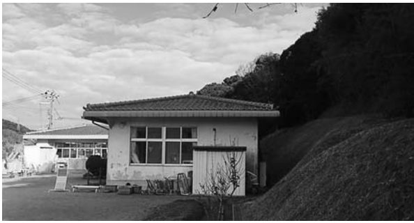
昭和53年建築の大町保育所
