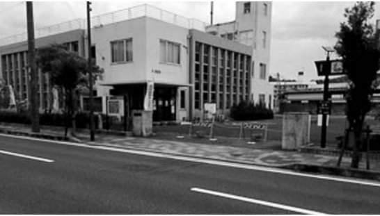
閉鎖している旧津名事務所
